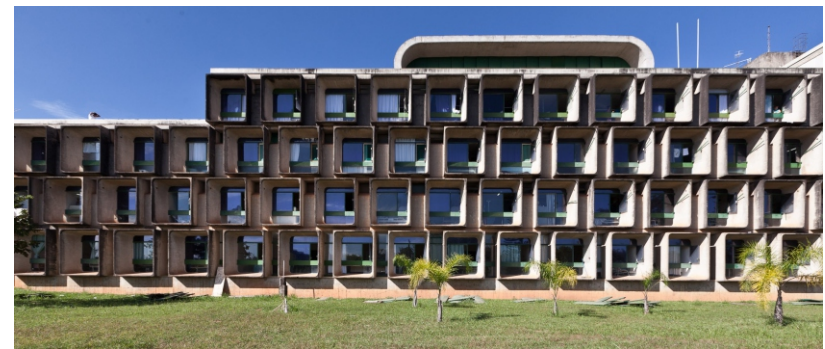
Figura 5.3. Foto do Hospital Distrital de Taguatinga e sua estrutura pré-moldada aparente, idealizada pelo arquiteto. Fonte: Joana França.
