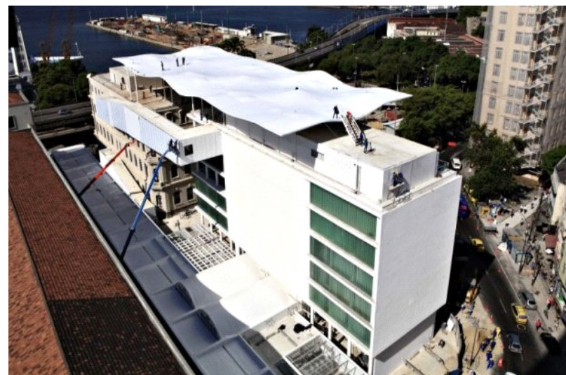
Figura 7.12. Imagem da colocação da cobertura que realiza o coroamento e a união dos dois edifícios. Fonte: JACOBSEN (2013).
